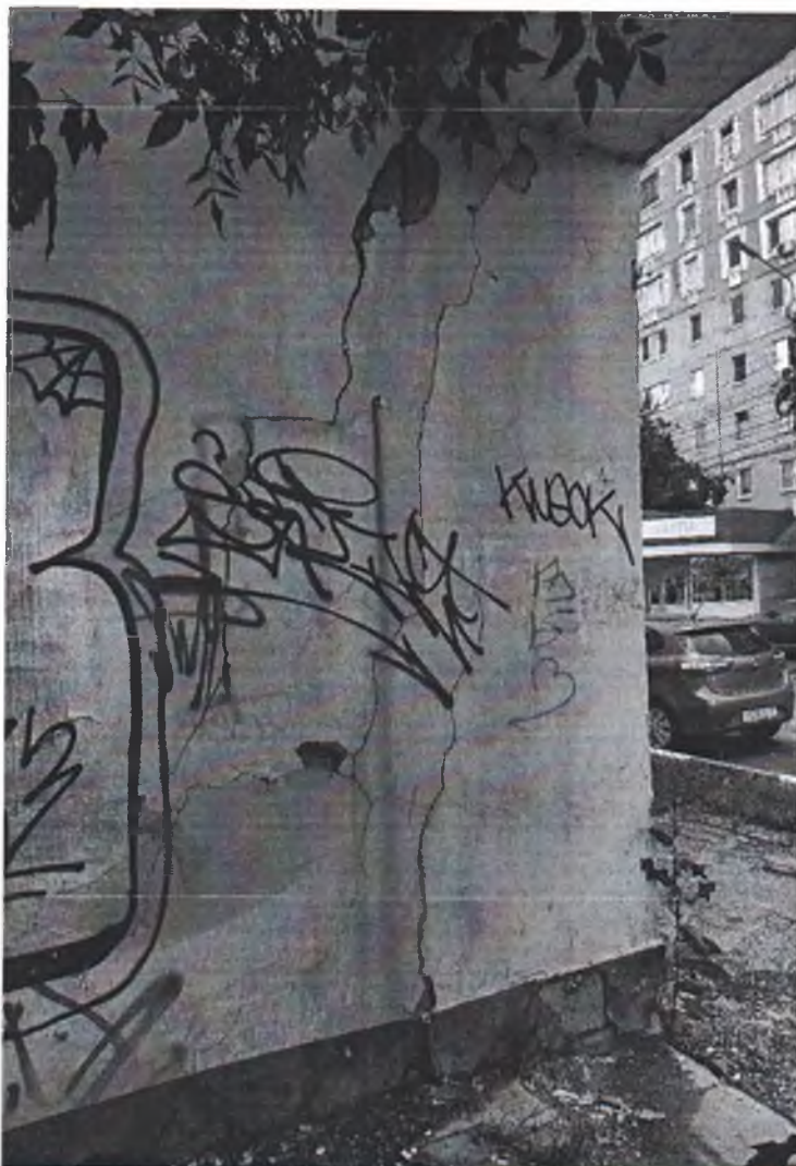
Фото 5. Трещины в кирпичной кладке (северо-восточный угол)
